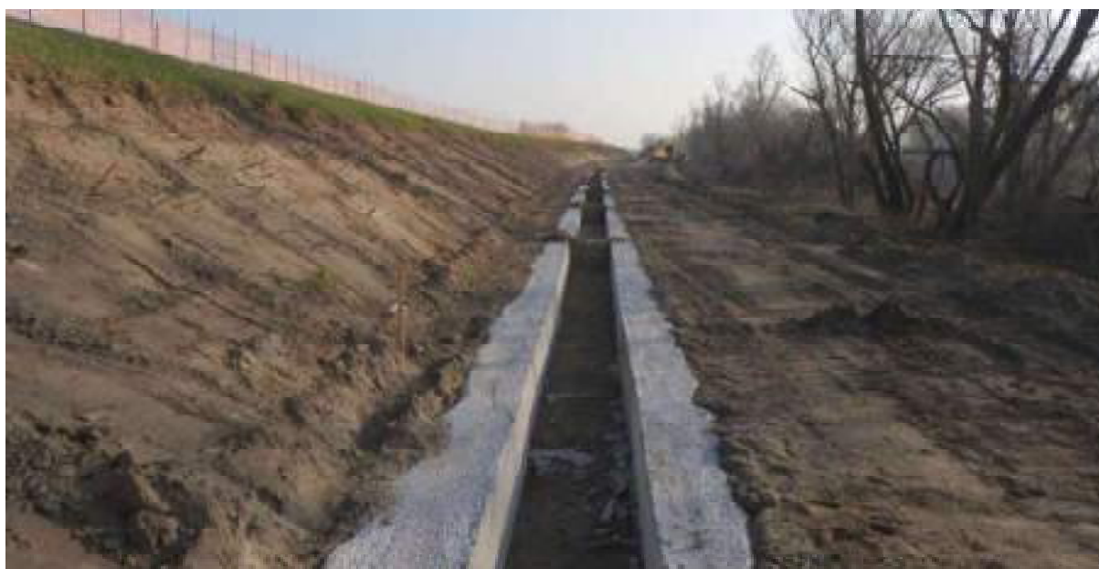
Figura 30. Esempio di diaframma realizzato
