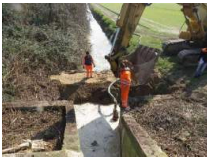
Figura 27. Fase di sostituzione di una chiavica
